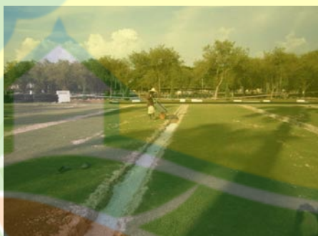
Gambar 3.8: Kerja-kerja mengorek lubang untuk penanaman corrugated and perforated subsoil pipe ( double wall HDPE ) bagi sistem saliran bawah tanah yang baru.
