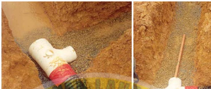
Gambar 4.9: Penimbang air digunakan bagi mendapatkan darjah kecerunan yang betul.
