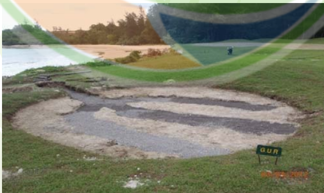
Gambar 3.11: Sistem saliran bawah tanah dipasang bagi tujuan pembaikan.
