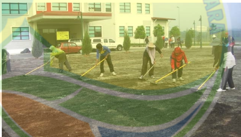
Gambar 4.17: Proses kerja pembajakan halus ( fine grading ) menggunakan pencakar ( rake ) sedang dibuat di kawasan penanaman turf.
