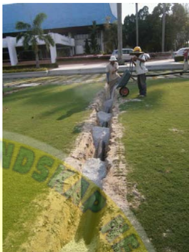
Gambar 3.8: Kerja-kerja mengorek lubang untuk penanaman corrugated and perforated subsoil pipe ( double wall HDPE ) bagi sistem saliran bawah tanah yang baru.
