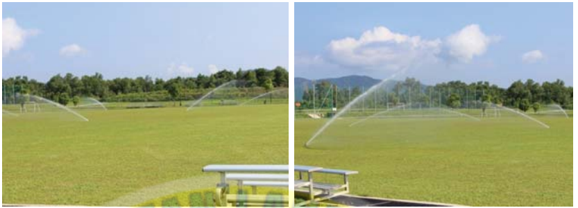
Gambar 3.1: Sistem penyiraman sprinkler jenis automatik yang digunakan di Akademi Bola Sepak Negara, Kuantan.
