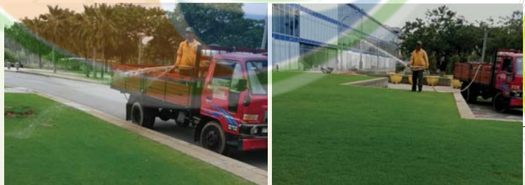
Gambar 4.14: Kerja penyiraman kawasan turf menggunakan kaedah tangki air bergerak.
