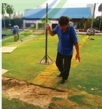
Gambar 3.9: Lubang corrugated and perforated subsoil pipe ( double wall HDPE ) ditutup dengan pasir, seterusnya kepingan sod ditanam secara rapat ( close turf ) dan kemudian kepingan sod dimampatkan.
