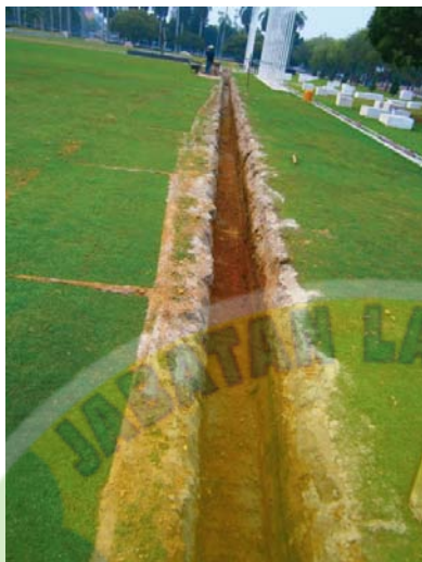
Gambar 3.8: Kerja-kerja mengorek lubang untuk penanaman corrugated and perforated subsoil pipe ( double wall HDPE ) bagi sistem saliran bawah tanah yang baru.
