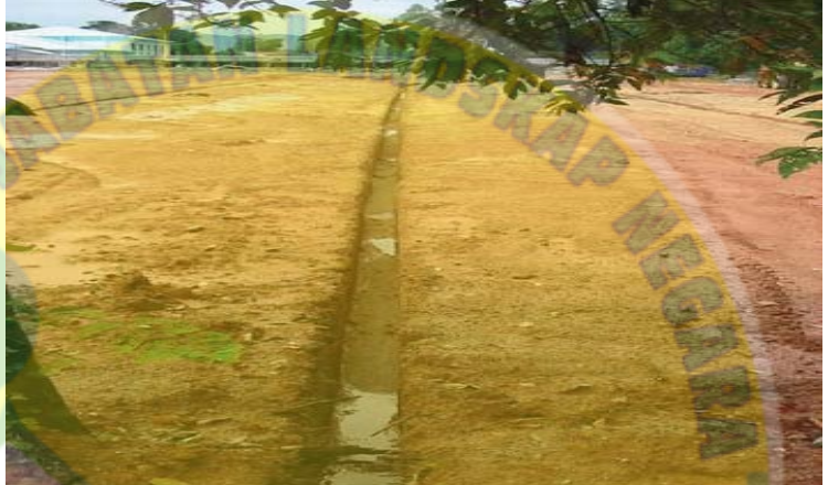
Gambar 4.7: Kerja-kerja persediaan kawasan bagi paip saliran bawah tanah.
