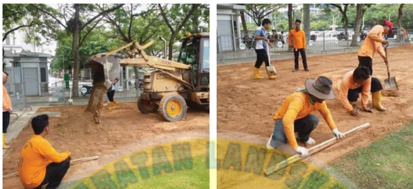
Gambar 3.13: Kerja-kerja pembaikan dilaksanakan dengan membongkah dan membuang kawasan turf yang telah rosak terlebih dahulu. Kemudian kawasan diratakan dengan pasir halus dan dimampatkan menggunakan jentera back hoe dan secara manual.
