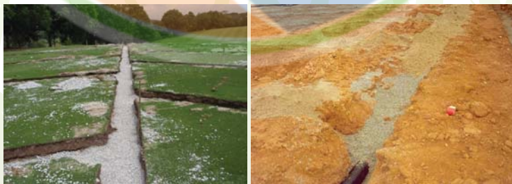
Gambar 4.11: Paip di tutup dengan batu agregat dan pasir sungai.
