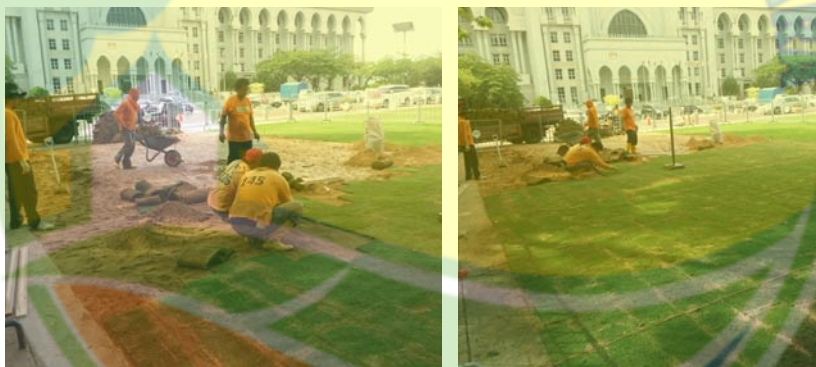
Gambar 3.14: Kerja-kerja penanaman turf dibuat secara rapat ( close turf ) setelah pasir halus diratakan dan dimampatkan dengan sempurna.
