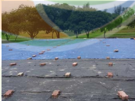
Gambar 4.2: Tapak penanaman turf perlu ditutup dengan kanvas semasa kerja-kerja fumigasi.
