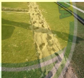
Gambar 3.8: Kerja-kerja mengorek lubang untuk penanaman corrugated and perforated subsoil pipe ( double wall HDPE ) bagi sistem saliran bawah tanah yang baru.
